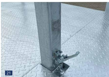
Mittelsäulen 100 x 100 mm, mit Niederspanner = Herausfallsicherung, verzinkter Tränenblechboden
